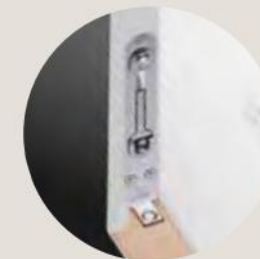
Edge bolt at the bottom
